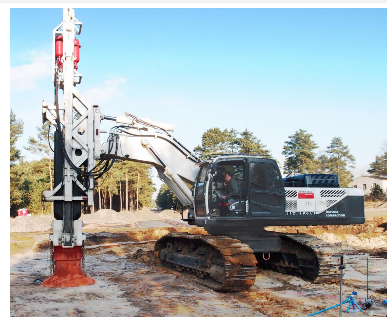
02 RAPID IMPACT COMPACTOR – PRINZIP HAMMER UND AMBOSS
