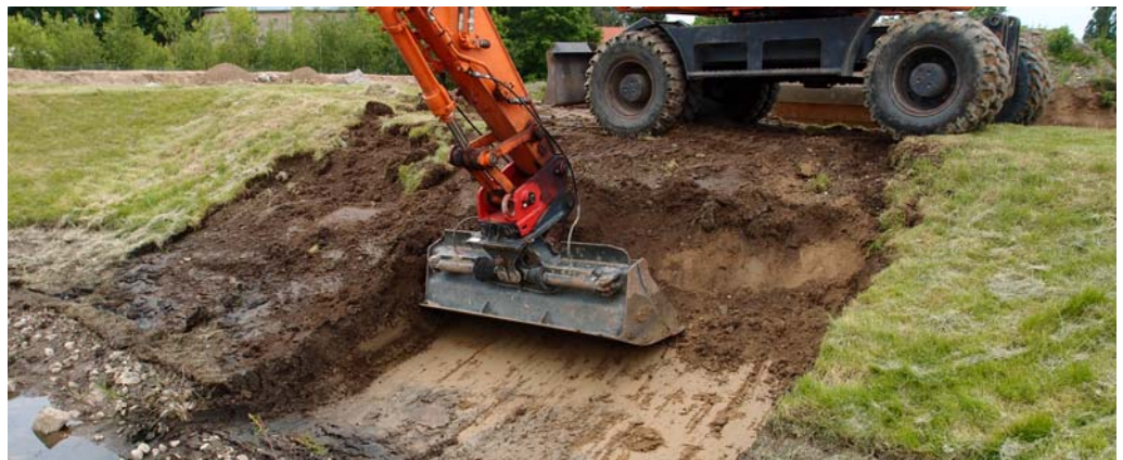
Recycling von Deichmaterial – direkt vor Ort: spart Ressourcen und Kosten
