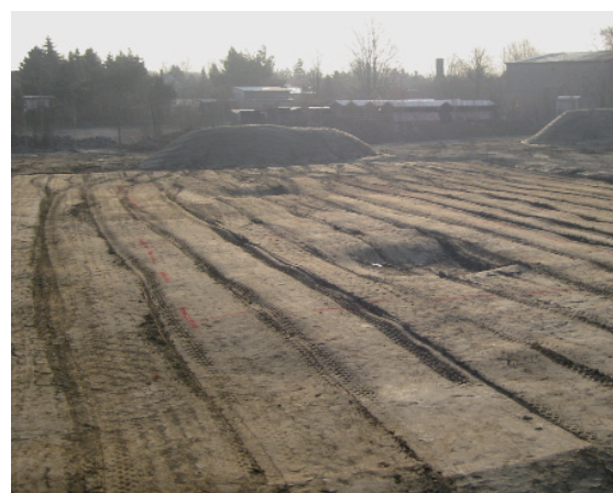
Verdichtung des Untergrundes
