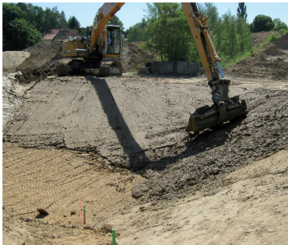
Flüssigboden-Einbau auf der Wasserseite
