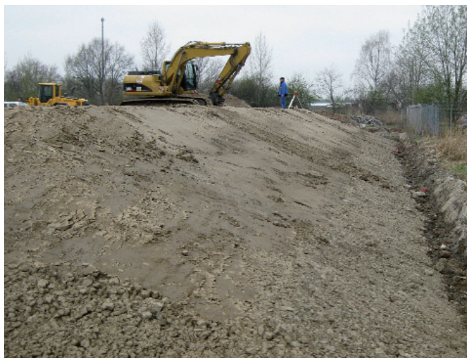
Stützkörperaufbau
