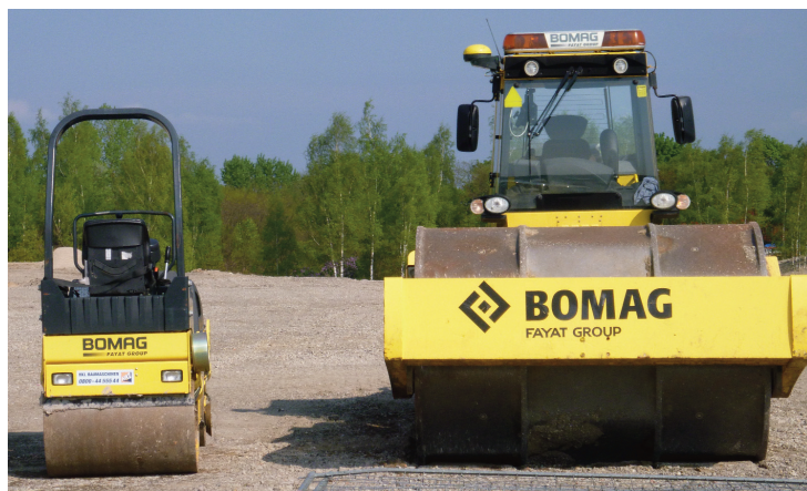
Erdverdichter im Baufeld
