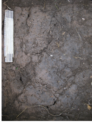
Abb. 2: Wurzeleinlagerung, Austrocknung und Rissbildung in einer gealterten Tondichtung
