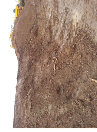
Abb. 1: stark durchwurzeltes Deichmaterial
